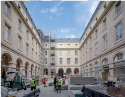
La grande cour en chantier
