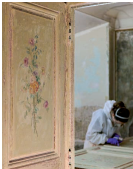
Décapage des couches de peinture
