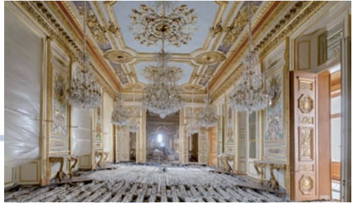
Les salons d'apparat en travaux
