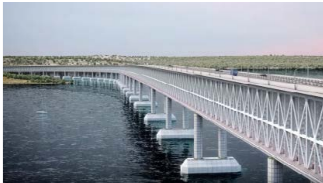
Une arche ferroviaire en voie de construction Dessin numérique du pont
